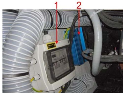
1. Zweipoliger Schutzschalter - Bordnetz & Klimaanlage
